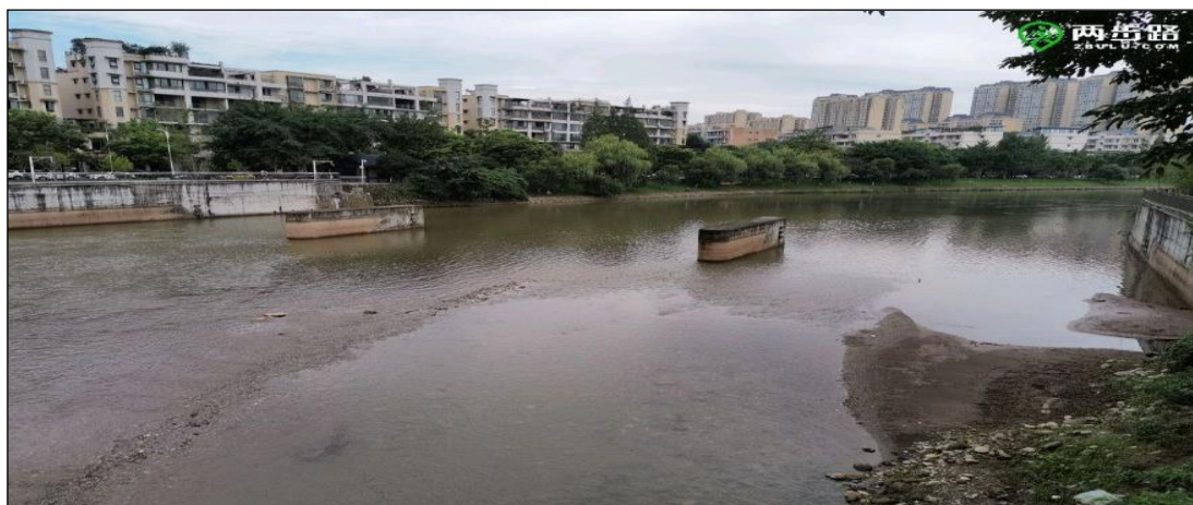
图 5-18 改 1#气盾坝（已翻坝）
