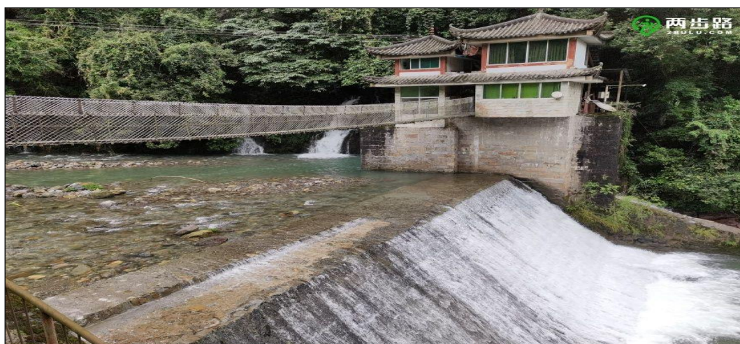
图 5-11 峨山电站取水口
