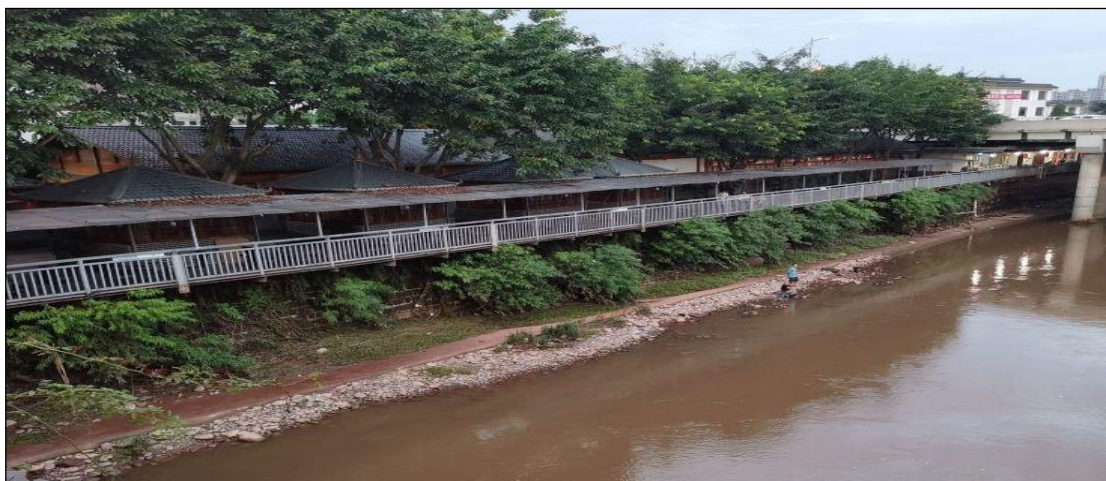
图 5-8 EMHS2 监测断面岸坡情况
