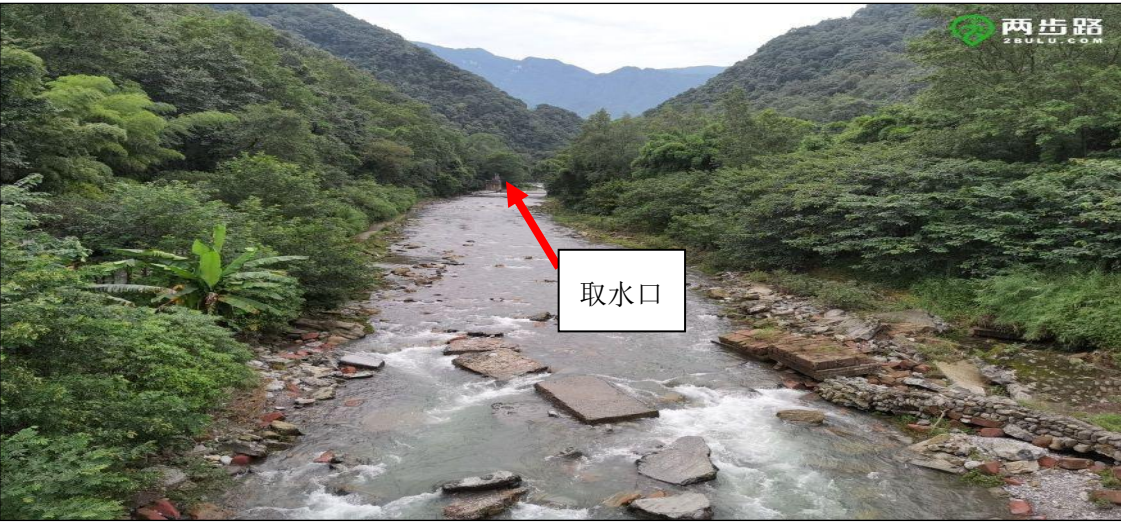
图 5-27 峨眉景区水厂、二水厂取水口
