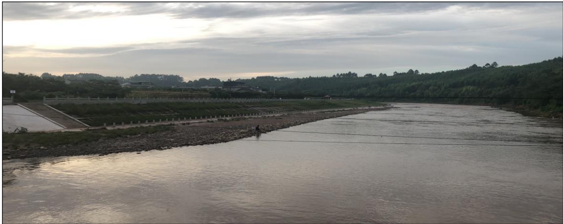
图 5-28 苏稽镇峨眉河防洪治理工程堤防
