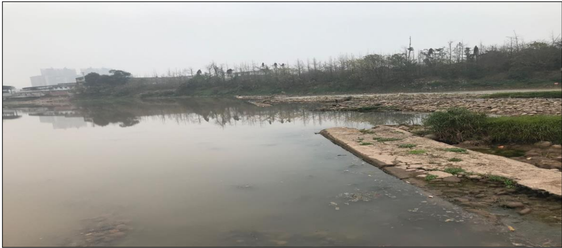
图 5-24 安福堰（已损毁）
